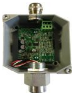
Sonda con Sensore da Sostituire
